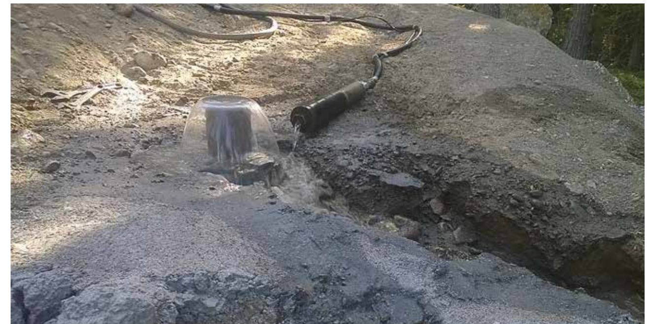
Paineukaisun jälkeen kaivosta tulee paineella vettä yli. Tämä on normaalia ja voi jatkua useamman tunnin ajan. Paineen tasoittuttua veden tulo rauhoittuu ja kaivoon voi asentaa pintaeristysputken sekä pumpun paikalleen.
